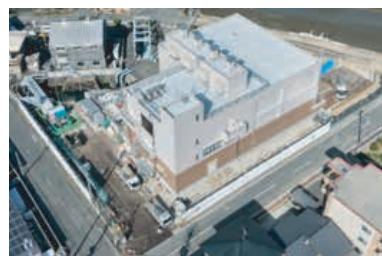
建設中の三川新ポンプ場
