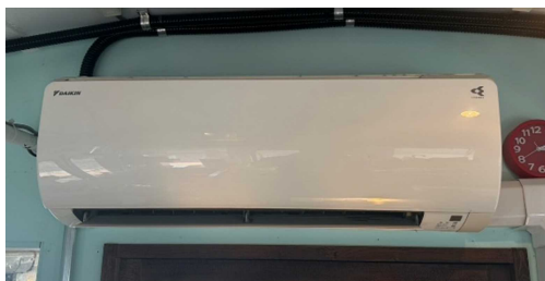
厨房用エアコン
