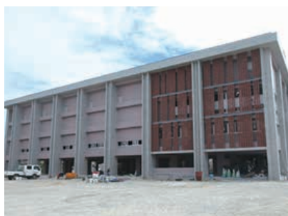
新しく建設された体育館は、以前より大きくなり、1階部分は駐輪場になります
