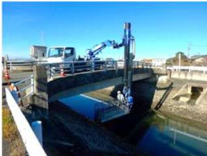
▲橋梁点検車による点検
