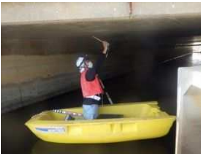
▲ボートによる点検
