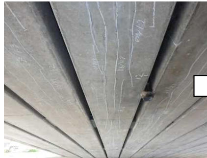
主桁にひびわれが確認されたので補修を行いました
