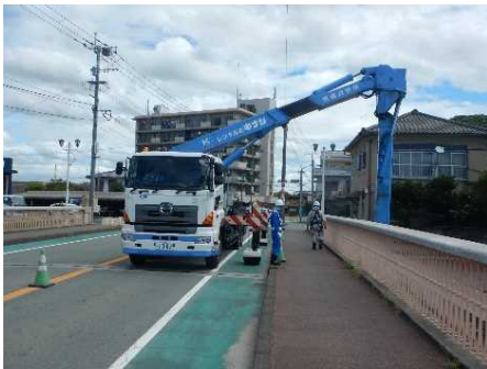
▲橋梁点検車による点検
