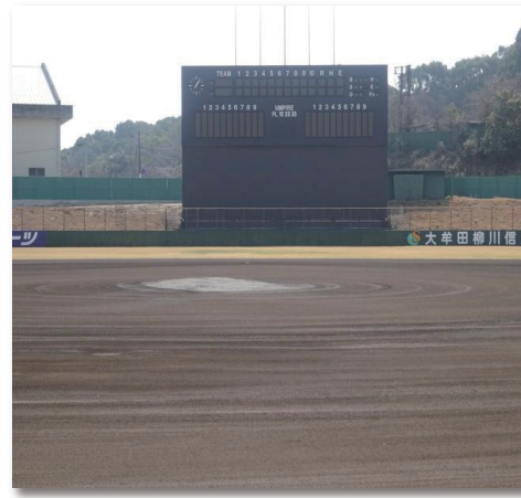
平成29年度 延命球場 スコアボード等改修
