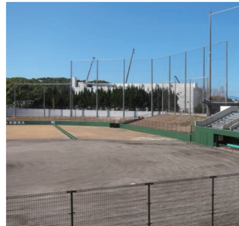
令和4年度 延命球場 大規模改修
