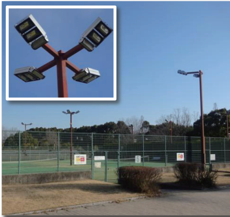
令和2年度 諏訪公園テニスコート 照明LED化改修
