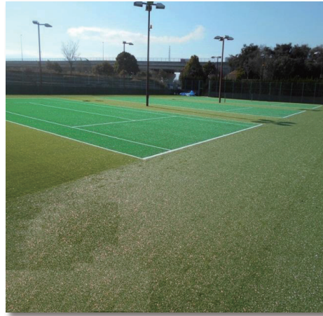
平成29年度 諏訪公園テニスコート 人工芝全面張り替え
