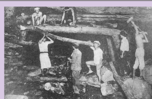
しくり 木をつかって、こう道（トンネル）を補強します。
