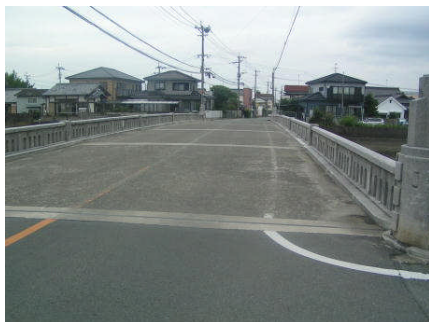
天領橋の歩道
