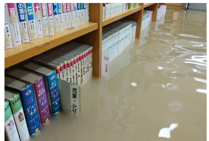
図書棚の下段の本が水に浸かっています。(1階ロビーへの浸水が分かります。)
