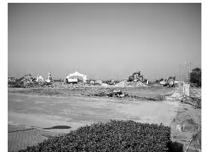
解体工事が進む 旧ネイブルランド跡地
