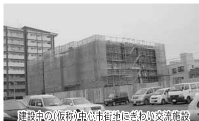
建設中の(仮称)中心市街地にぎわい交流施設
