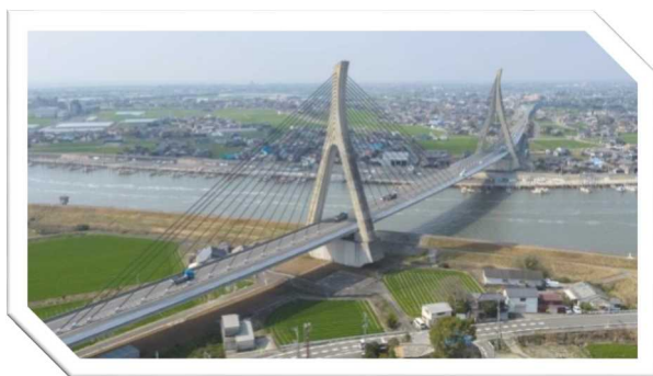
矢部川に架かる矢部川大橋
