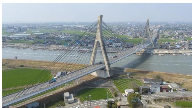
矢部川に架かる矢部川大橋
