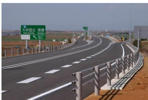
有明海沿岸道路（大牟田北 | C付近）
