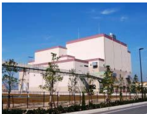
大牟田・荒尾 RDF センター
