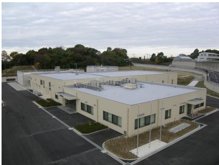
ありあけ浄水場
