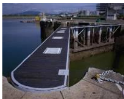
三池港 閘門（大牟田市）
