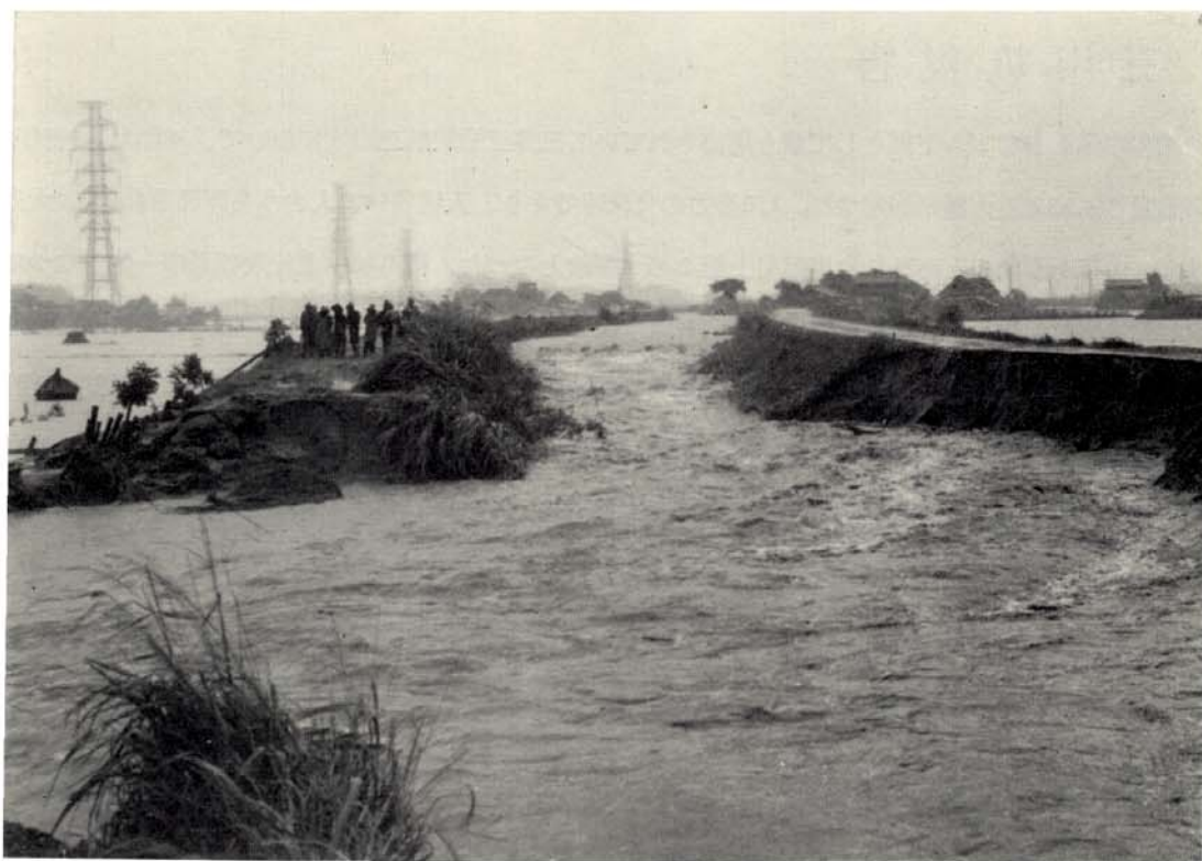
白銀川堤防決壊箇所
