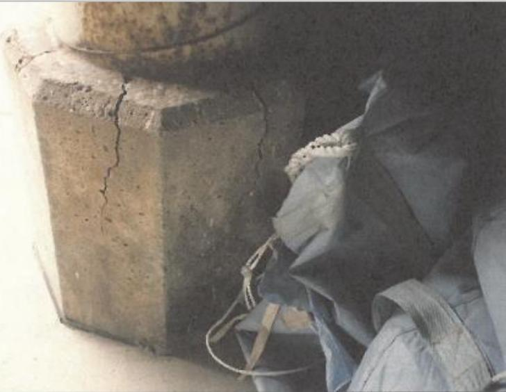
広告塔脚部コンクリート基礎のひび割れ
