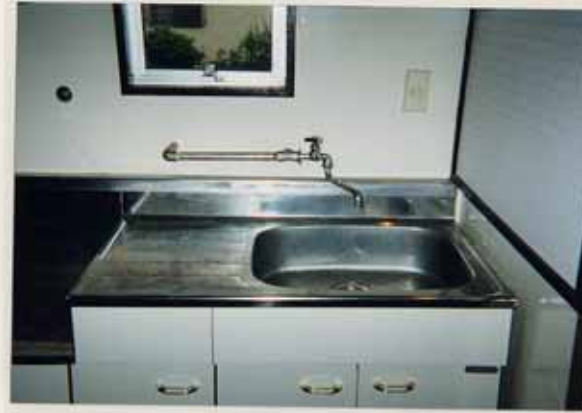
パッキン交換
