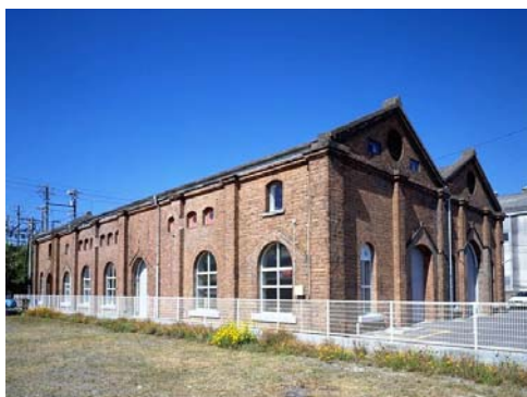
旧三川電鉄変電所
