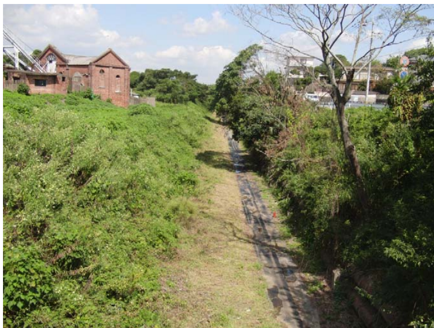
東金ヶ坂橋から眺める鉄道敷と宮原坑跡
