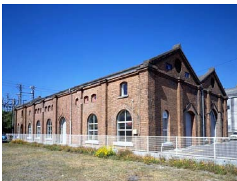
旧三川電鉄変電所
