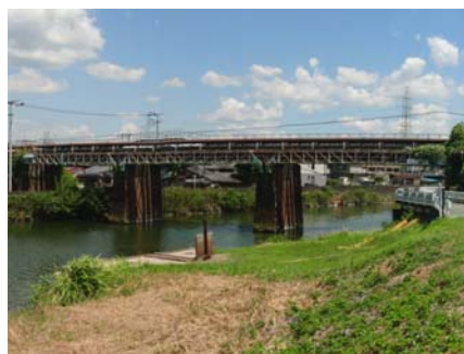
旧三池炭鉱専用鉄道敷諏訪川鉄橋
