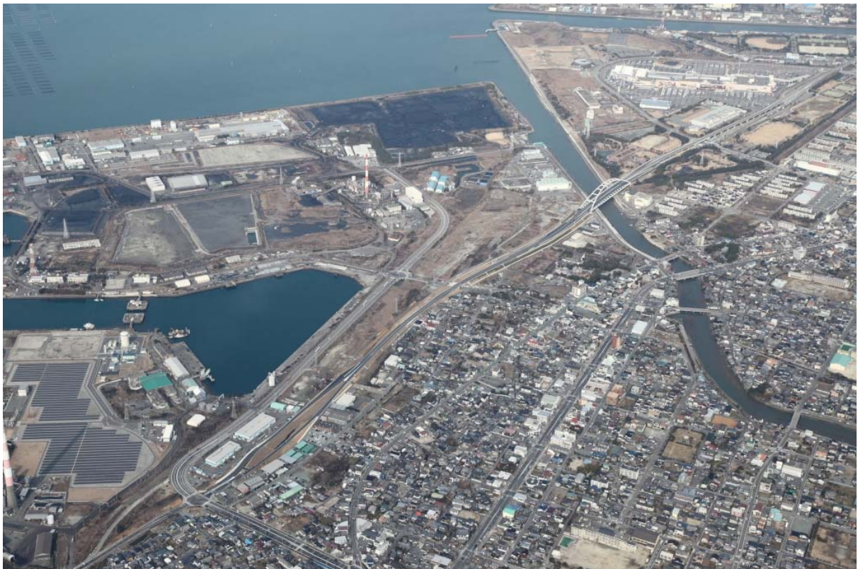
有明海沿岸道路、国道 389 号、諷訪川、諷訪公園
