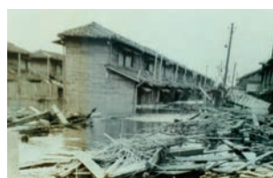
昭和17年台風16号による高潮被害（市内）
