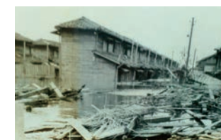
昭和17年台風16号による高潮被害（市内）
