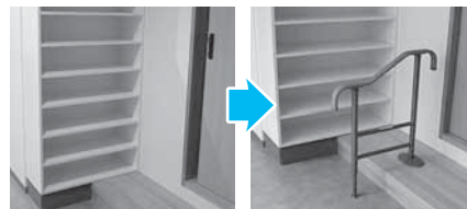
和室入口の段差に手すりを設置
