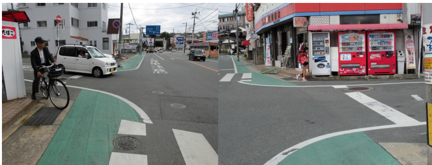
県道藤田～上官2丁目（一方通行路の出口付近）
