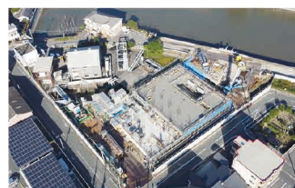
整備が進む三川新ポンプ場
