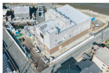
建設中の三川新ポンプ場
