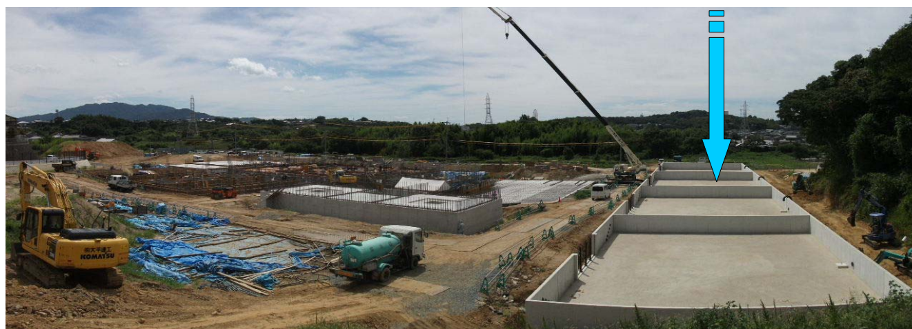
共同浄水場工事現場 全景
