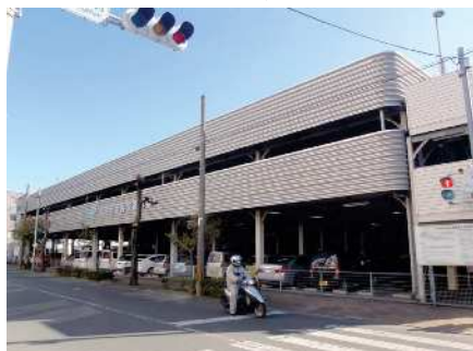
駐車場 道路側から撮影
