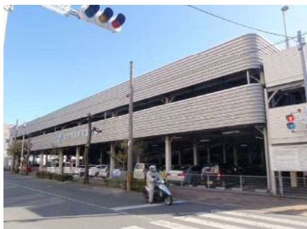
駐車場 道路側から撮影
