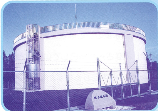
勝立配水池 平成15(2003)年完成
