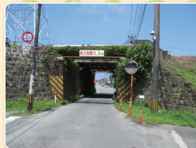
みぞこしかどうきょう 溝越架道橋
