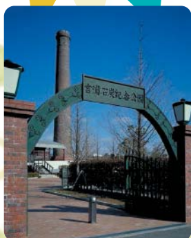
旧三池炭鉱宮浦坑煙突
