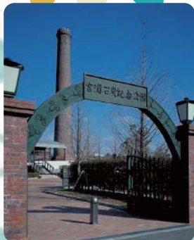
旧三池炭鉱宮浦坑煙突
