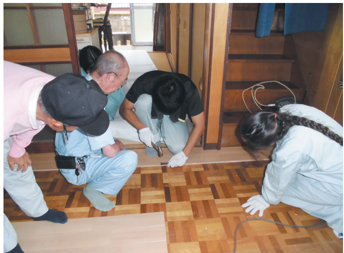
空き家の利活用（有明高専生による改修の様子）
