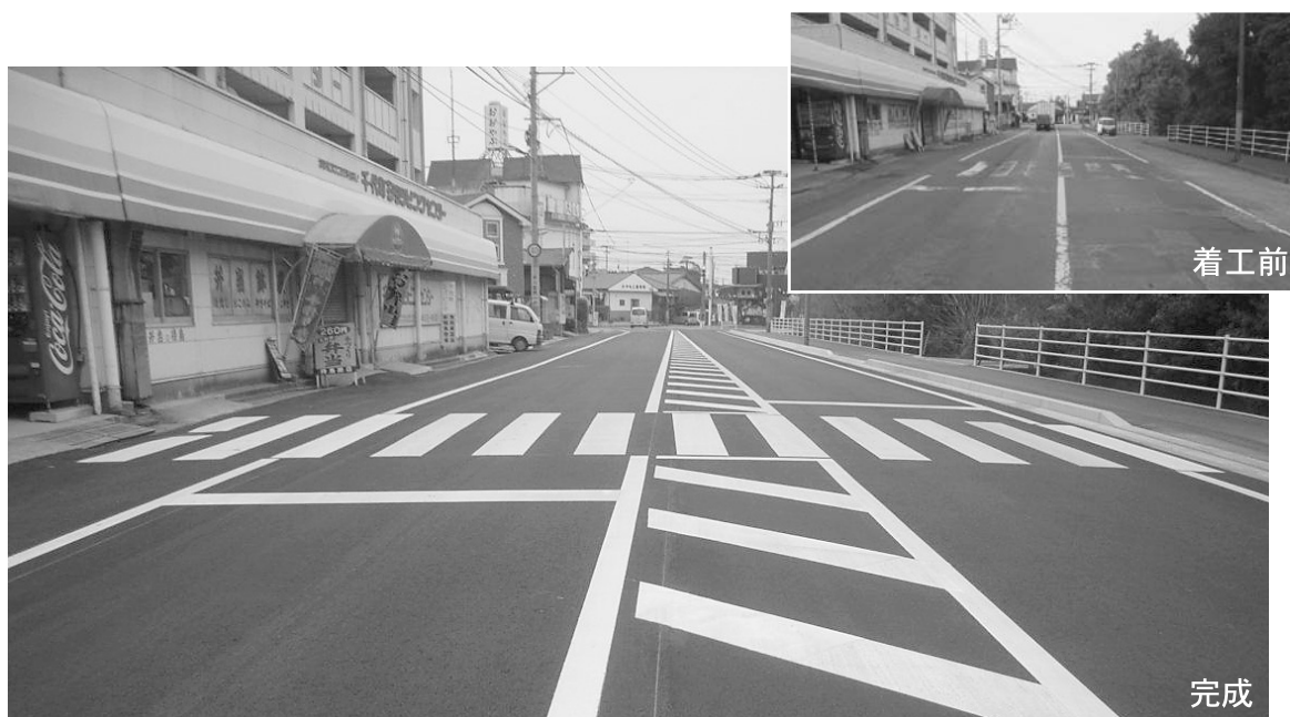
市道正山町浜田町線舗装改良工事（千代町）
