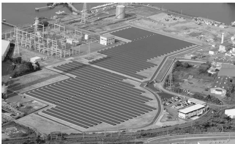
メガソーラー大牟田発電所
