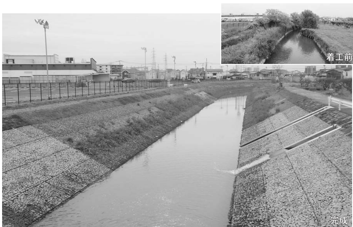
手鎌野間川河川改修工事
