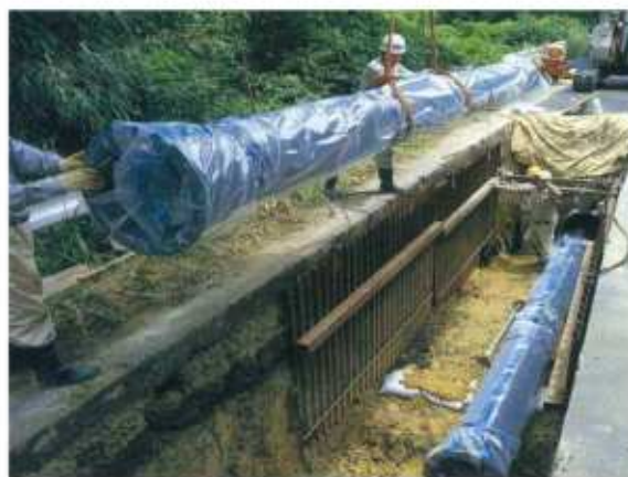
管路の布設状況
