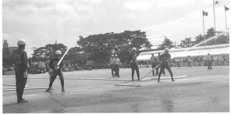
2線延長時の放水状況
