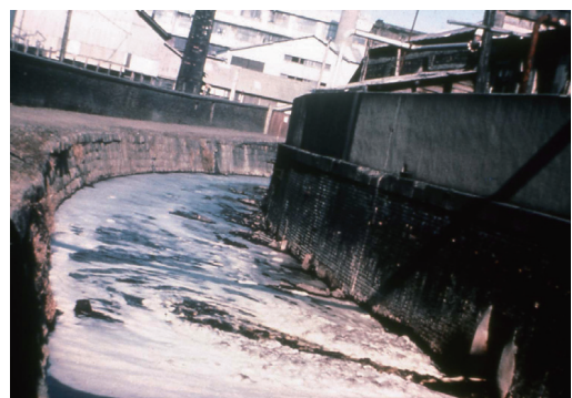
工場排水が流れ、汚れていた大牟田川
