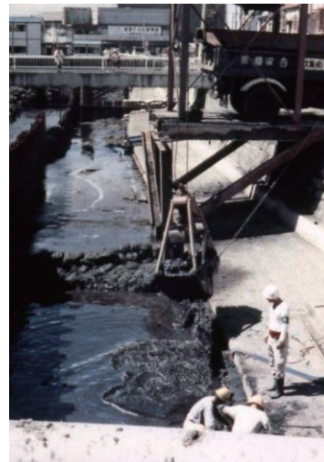
おおむたがわ 大牟田川の底にたまったへドロを取りのぞく様子
